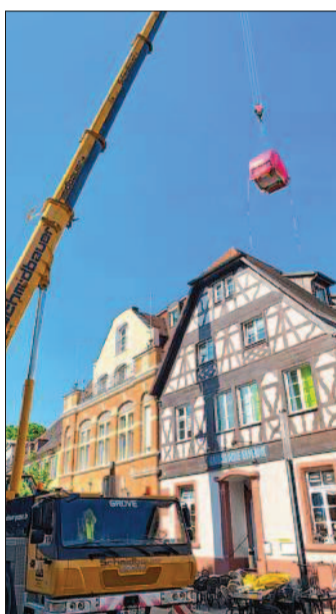
Vom Klostervorplatz aus wurde das tonnenschwere MRT-Gerät über die Dächer gehievt und zentimetergenau durch eine Lücke in der Hauswand in der radiologische Praxis eingepasst.
